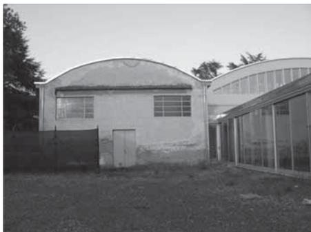
I padiglioni erano collegati da una tettoia coperta. Le coperture dei padiglioni, previste inizialmente piane, vennero successivamente eseguite a volta, su progetto dell'Ing. Frisa, con l'impiego di strutture in calcestruzzo armato, così come la caratteristica copertura di raccordo tra i due padiglioni.
