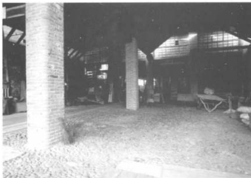
Laboratorio Cassina in Via Cavigioli oggi: il padiglione della segheria con le grandi coperture in legno ed i binari della decauville per il trasporto dei tronchi ancora ben conservati (Foto Bedoni)
