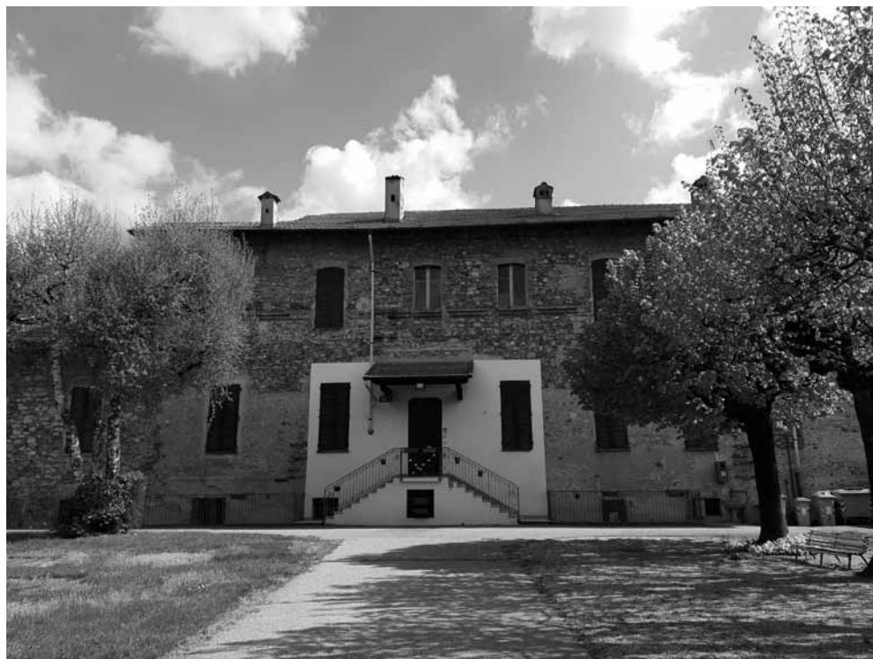
Palazzo d'Este oggi
